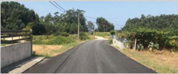
Rua dos Queimados, Esgueira
