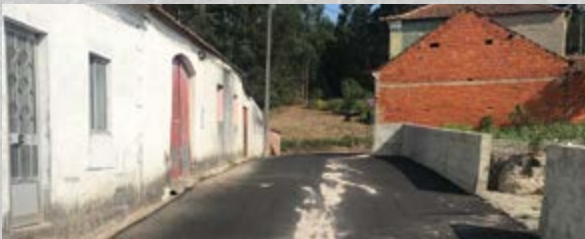
Travessa do Gorgulho, Carregal
