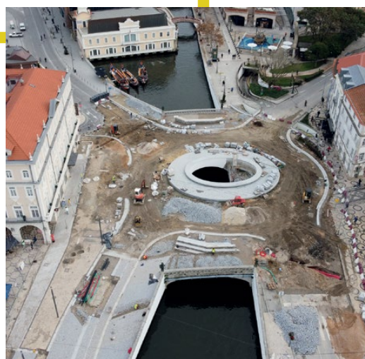
Obra em curso nas "Pontes"
