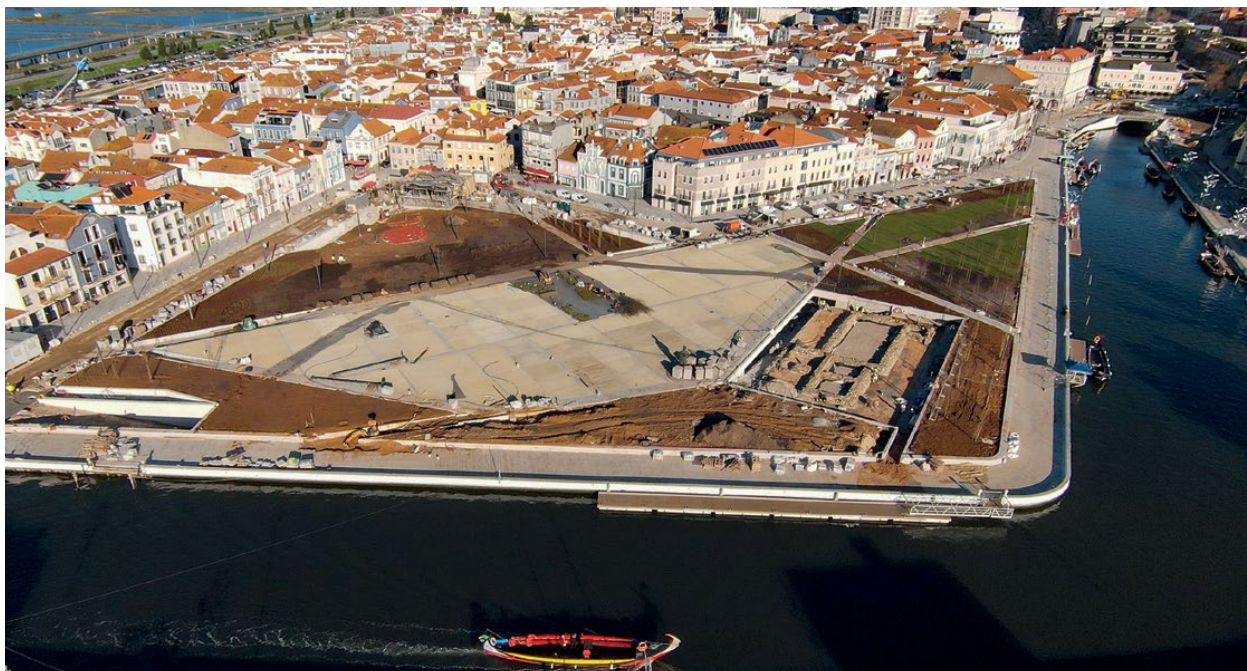
O novo Rossio em fase final de execução, onde já é possível perceber a área verde e a zona da praça
