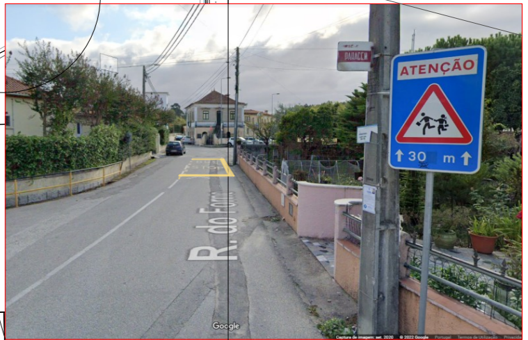
Proposta de novo alinhamento e criação de passeio com 1,20m de largura, para troço da Rua do Forno onde existe paragem de autocarro.
