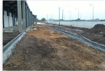
Execução de arranjos exteriores
