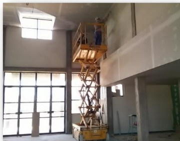
Montagem de tetos falsos
