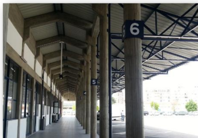
Fase Final - Zona do Cais
