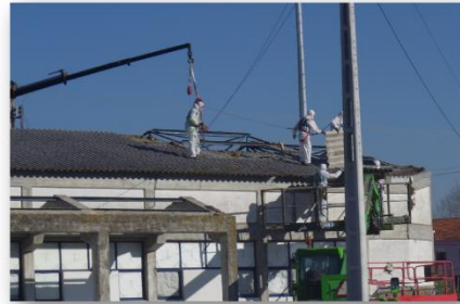
Remoção de placas de fibrocimento
