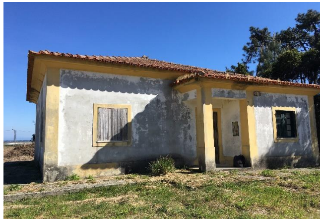
Figura 11: Edifício receção / clínica do Centro de Recuperação de Fauna Silvestre desativado
