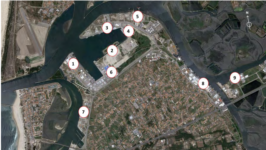
Figura 8: Instalações portuárias do Porto de Aveiro
